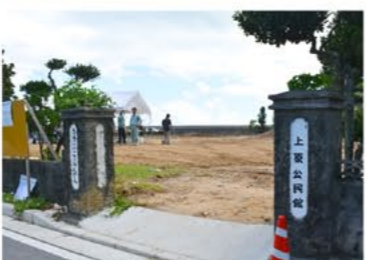
scene 07 上原集落 地鎮祭 「上原公民館」跡地で地鎮祭の準備が始まる。こちらの撮影準備OK。
