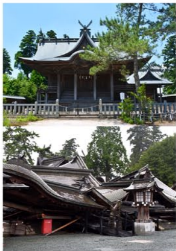
「一の神殿」、3つの神殿が美しく修理されていた。よかった。下の写真は震災後、2ヶ月の姿だ・・・、参拝に来た人の心を奪うありさまです。
