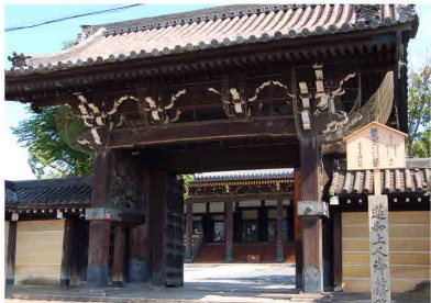
改修前の「本願寺別院」山門
