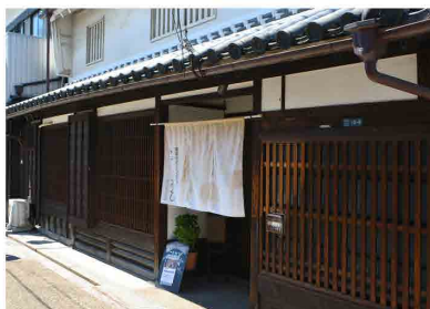
大工町筋に面した「農家のオーベルジュこもれび」の外観です。
