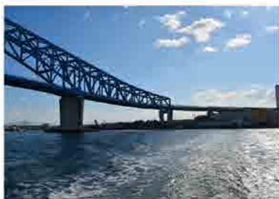
トラス橋+アーチ橋のハイブリッド「千歳橋」
